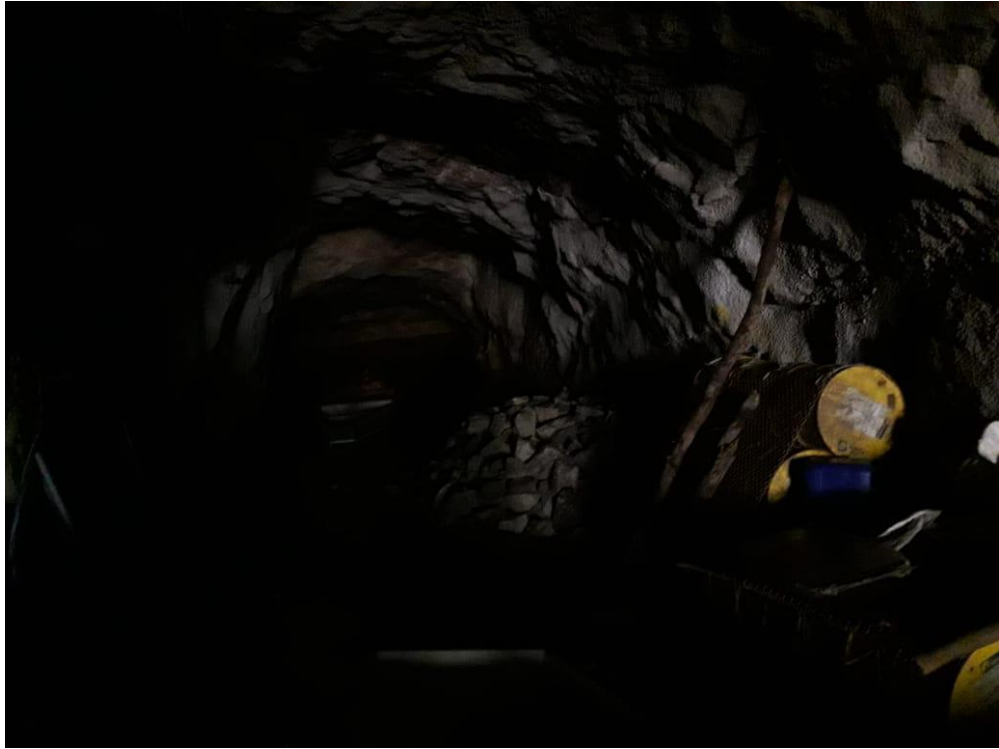
Imagem 9 - Situação atual do Túnel do Tibau
