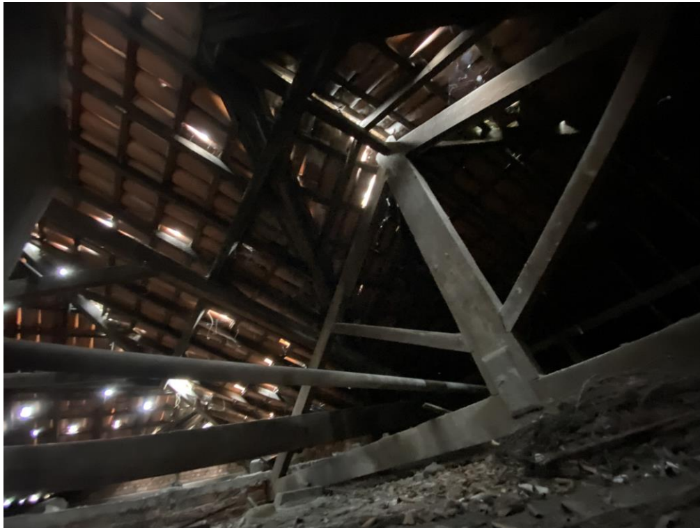
Foto 9 – Vista do telhado pela abertura no forro do teto do banheiro.
