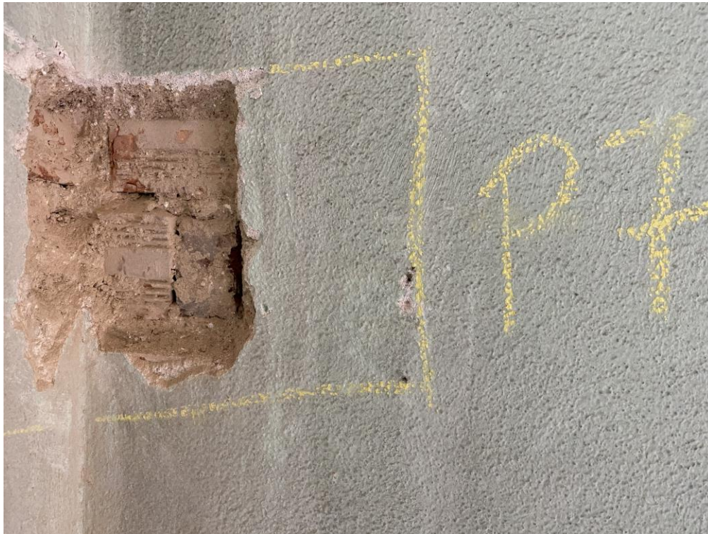
Foto 7 – Prospecção (P7) no canto dos fundos direito do quarto 5, onde se encontrou a parede de tijolos vazados.
