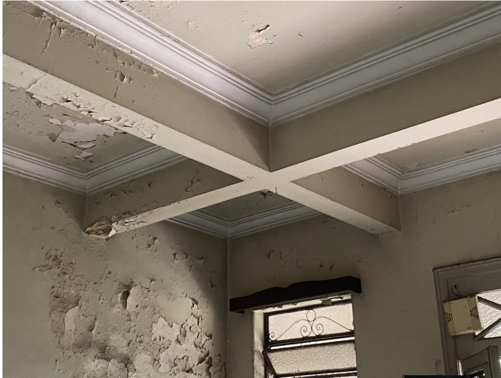
Foto 3 – Vigas de concreto armado na copa.
