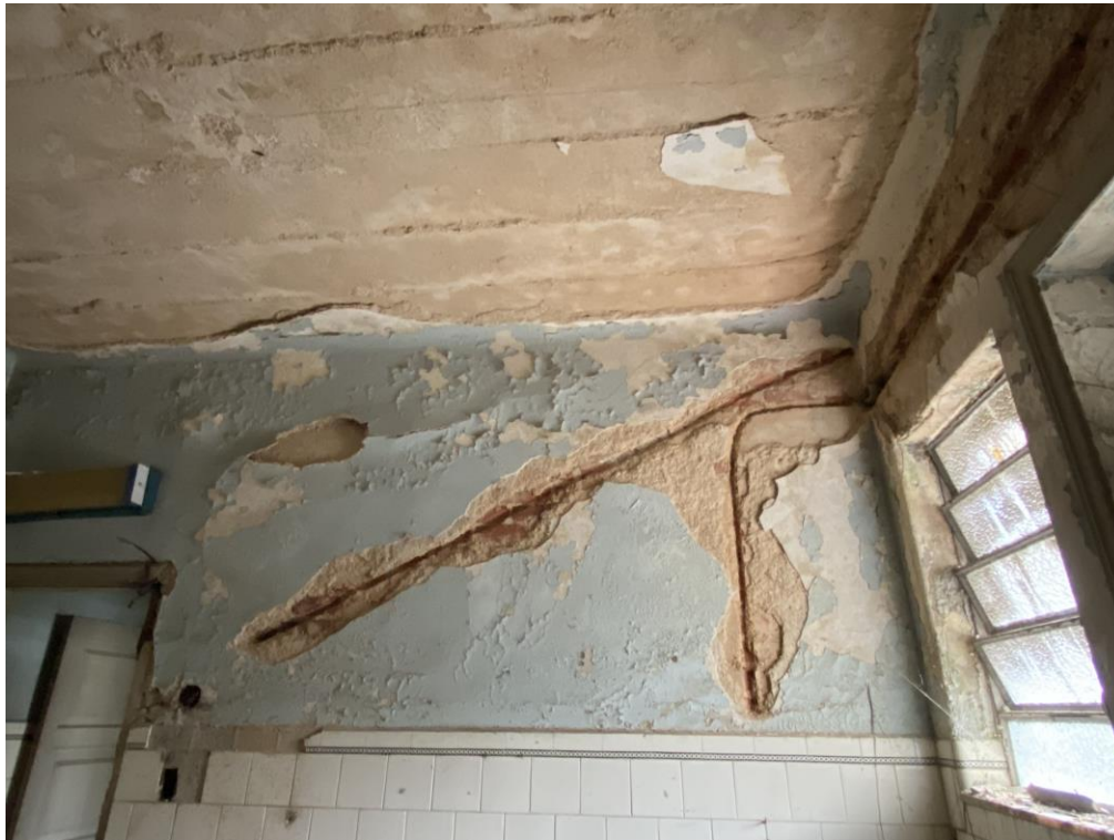
Foto 4 – Laje em concreto armado
