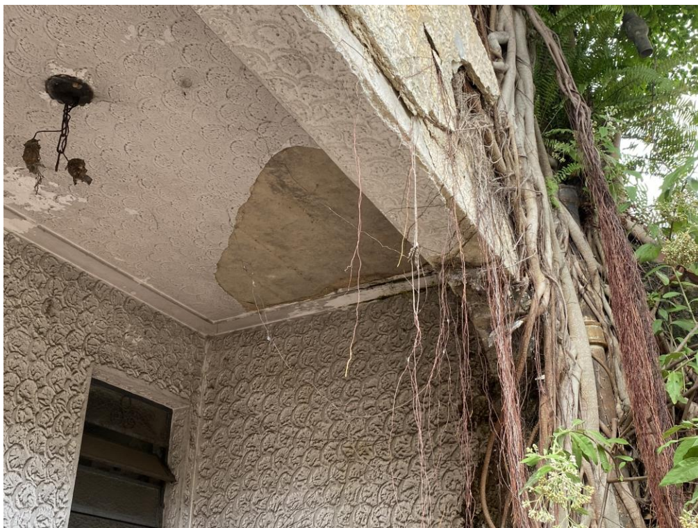
Foto 5 – Vista da varanda lateral com a laje e viga de bordo em concreto.
