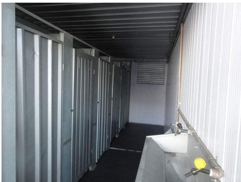
Figura 4 – Vista interna de contêiner vestiário com as cabines de chuveiros para banho. Fonte: Empresa API, 2020.
