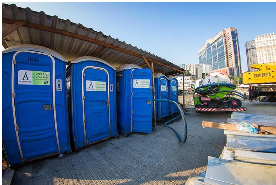
Figura 1 – Vista geral dos banheiros químicos e do caminhão ao fundo realizando a limpeza e coleta de efluentes para transporte e destinação. Fonte: Empresa Actionsshop, 2020.
