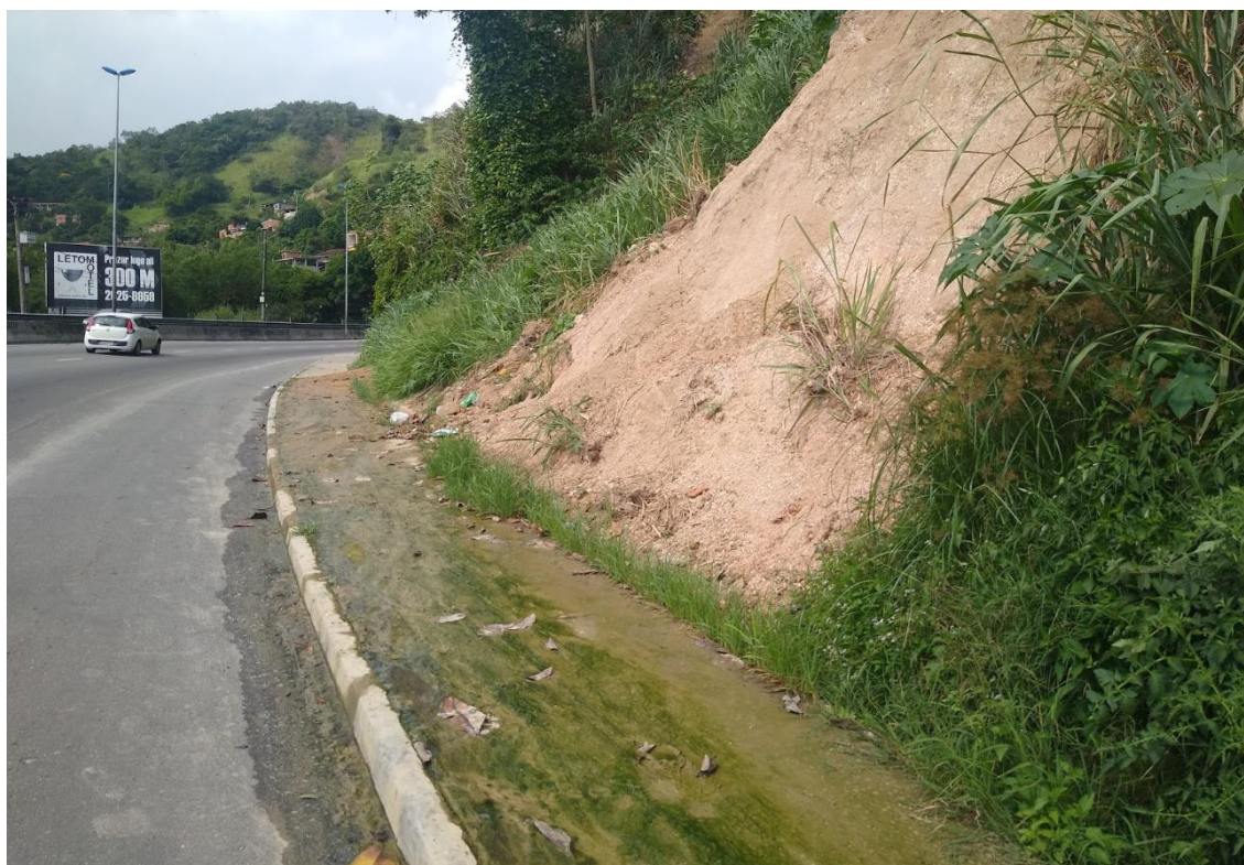
Esgoto sendo despejado na Rodovia
