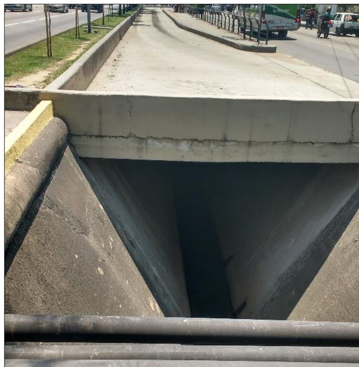
Figura 04 – Último Trecho do Canal na Alameda
