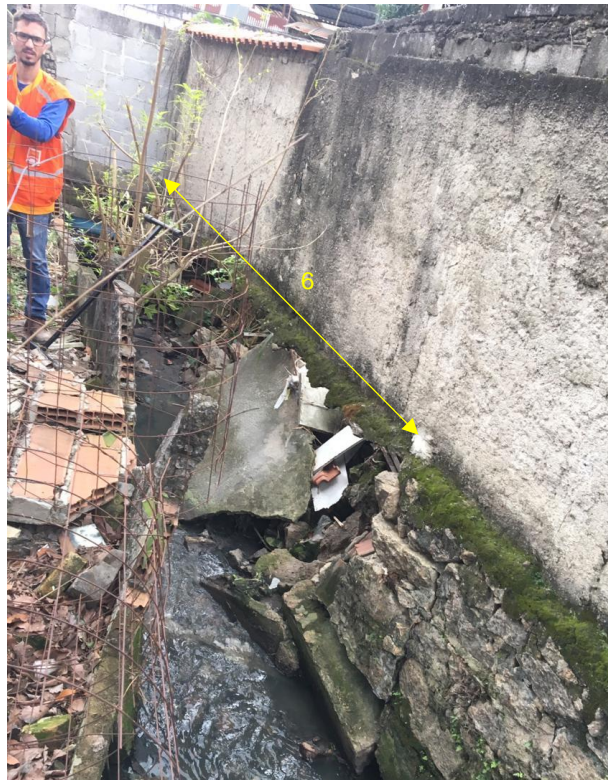
5a – vista externa da ruptura do muro de contenção da margem do rio.
