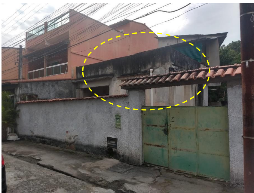
Figura 4 – vista da fachada da edificação.
