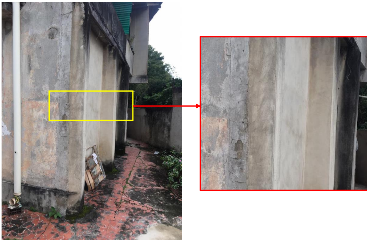
Figura 13 - pilares salientes ao volume da edificação
