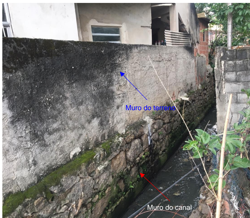
Figura 3 – Vista externa do muro do terreno sobre o muro do canal.
