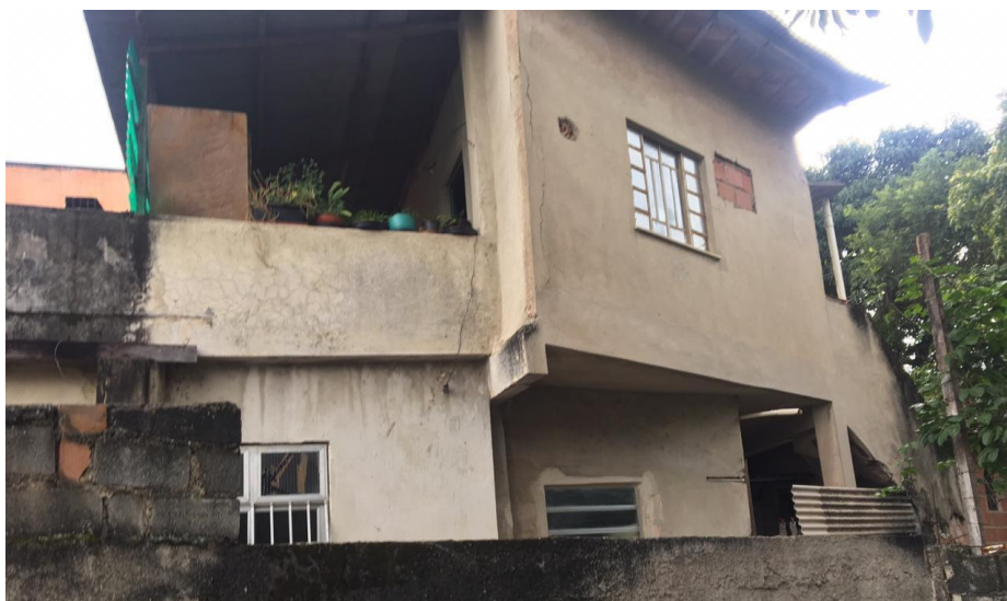
Figura 2 – Vista da lateral direita da construção.
