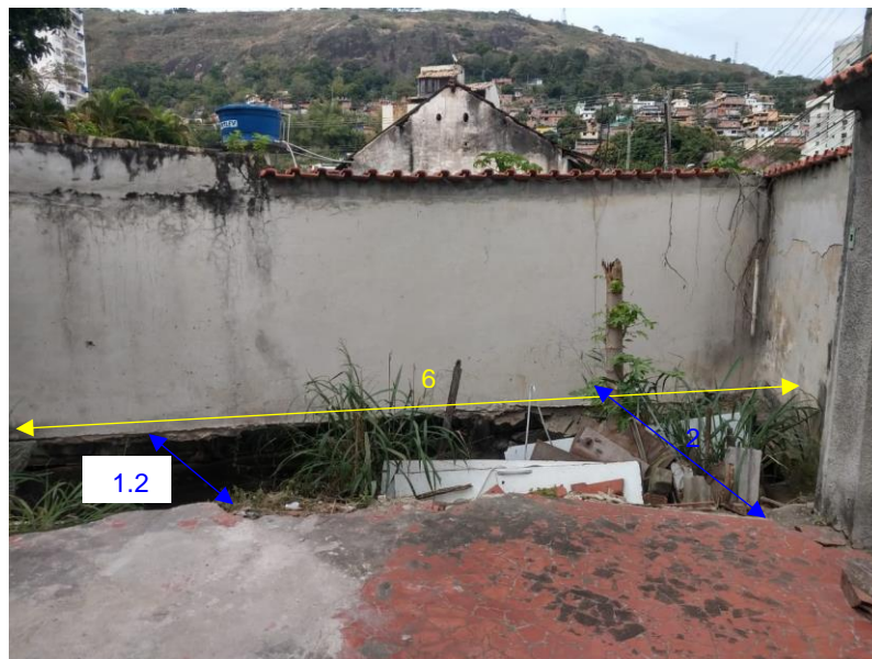
5a – vista externa da ruptura do muro de contenção da margem do rio.
