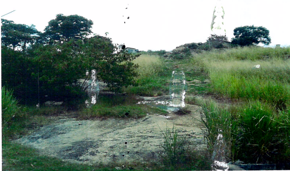
Fotos nº.9 – Mostrando em continuação da foto anterior, o trecho onde indicamos criar uma pista de acesso até à parte abaixo do ponto de recolhimento do lixo (ponto acima e no centro na foto) com utilização de terraplenagem e algumas contenções de pequeno porte.
