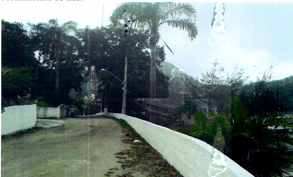
Fotos nº.5 – Mostrando trecho da pista de acesso interno do clube desde a entrada até o ponto de recolhimento do lixo.
