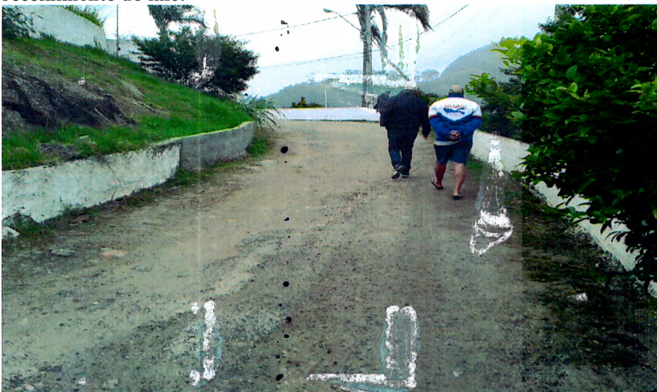
Fotos nº.6 – Mostrando trecho da pista de acesso interno do clube desde a entrada até o ponto de recolhimento do lixo.
