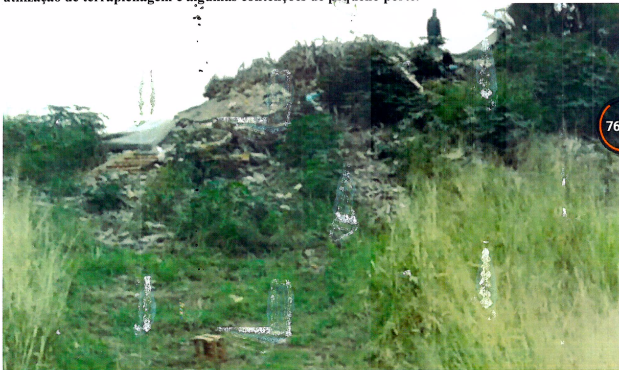
Fotos nº.11 – Mostrando em detalhe ponto da foto anterior onde está se formando um lixão, acumulado pela comunidade na vizinhança e no interior do terreno do Jurujuba Iate Clube, possível de ser visto por quem navega pela enseada de Jurujuba.
