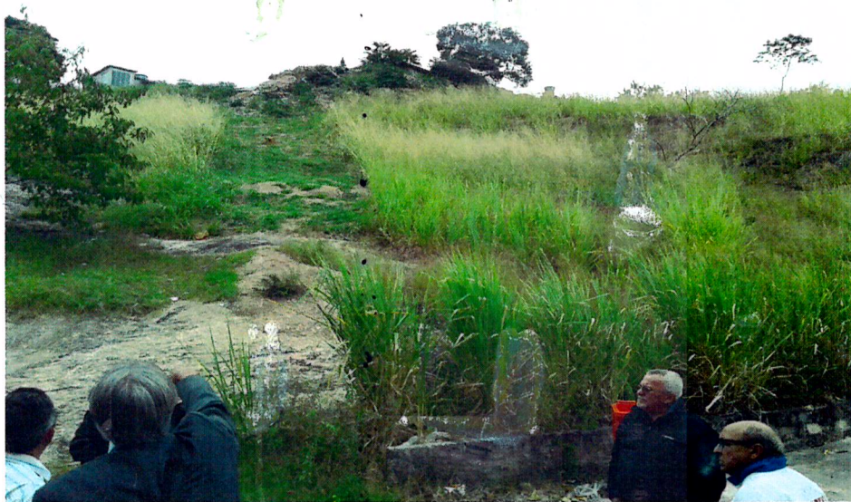
Fotos nº.10 – Mostrando em continuação das foto anteriores, o trecho onde indicamos criar uma pista de acesso até à parte abaixo do ponto de recolhimento do lixo (ponto acima e no centro na foto) com utilização de terraplenagem e algumas contenções de pequeno porte.
