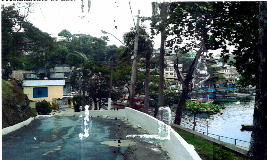
Foto nº.3 – Mostrando trecho da pista de acesso interno do clube desde a entrada até o ponto de recolhimento do lixo.
