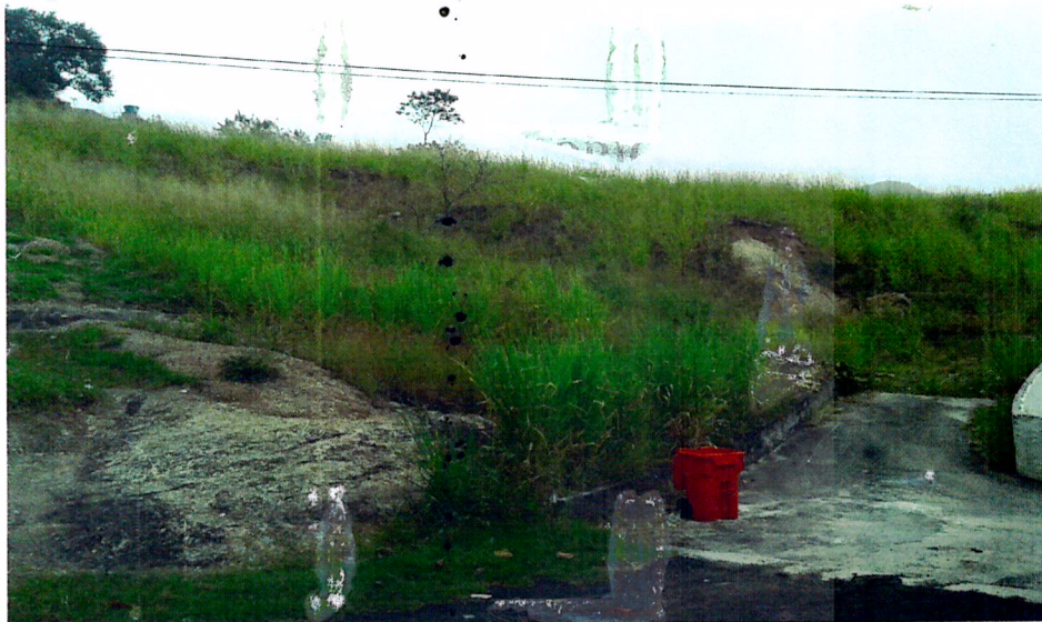
Fotos nº.8 – Mostrando trecho onde indicamos criar uma pista de acesso até à parte abaixo do ponto de recolhimento do lixo com utilização de terraplenagem e algumas contenções de pequeno porte.
